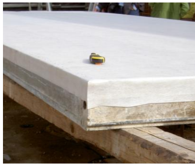
Zemdrain® MD selbstklebend auf der Schalung montiert
