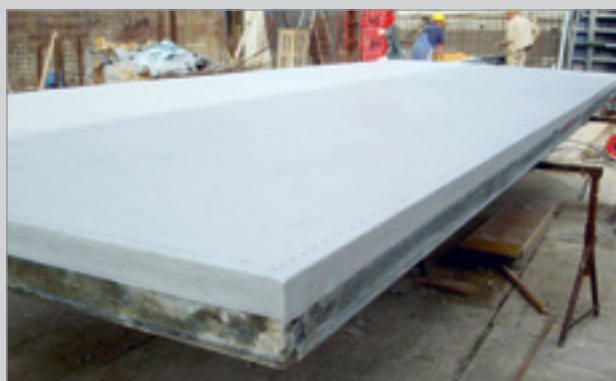
Mit Zemdrain® MD fertig bespannte Stahlrahmenschalung
