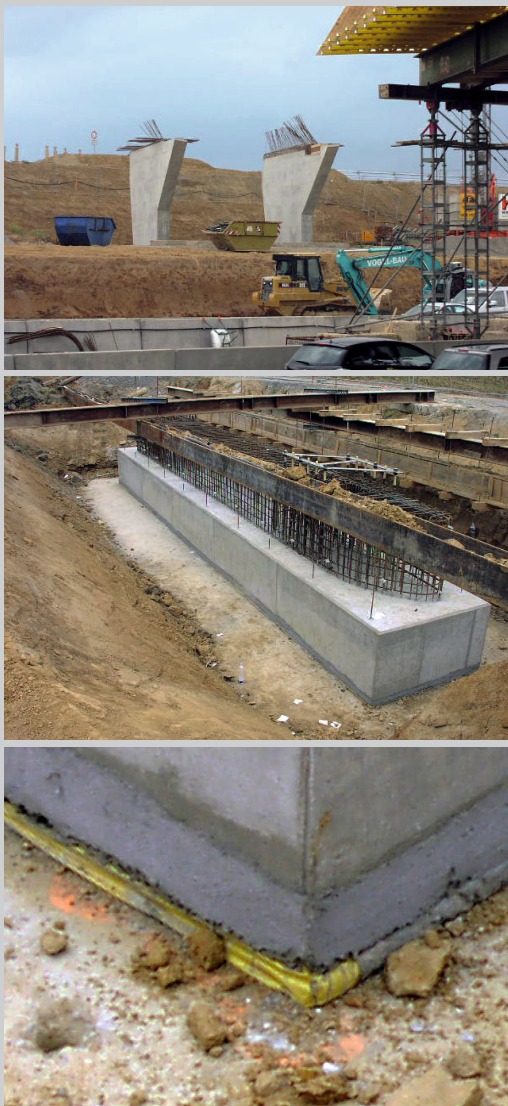
Brückenpfeiler einer Autobahnüberführung
